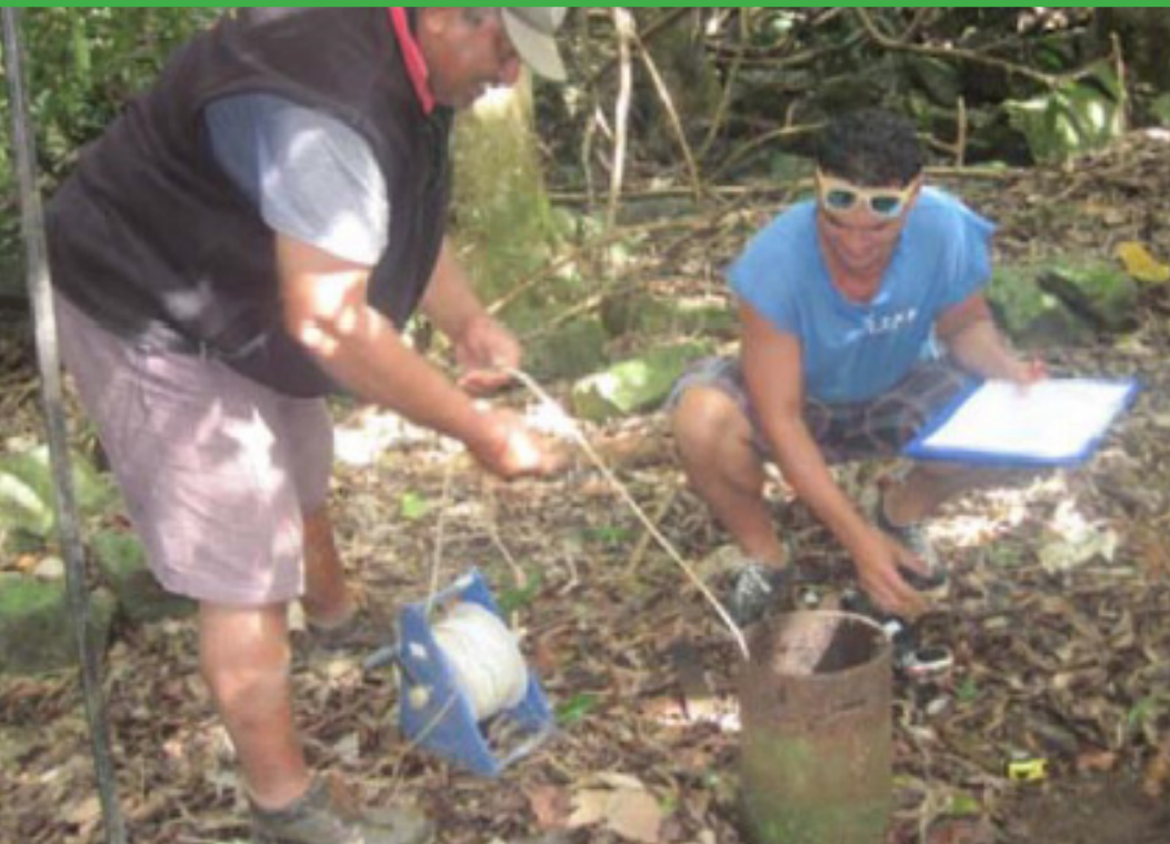
• Jimmy, responsable du service hydraulique de la commune de Tubuai mesure le niveau d'eau du forage.
