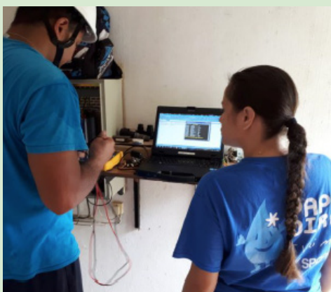
• Diagnostic des installations — Société Polynésienne des Eaux et Anaëlle Drollet (SPCPF)
